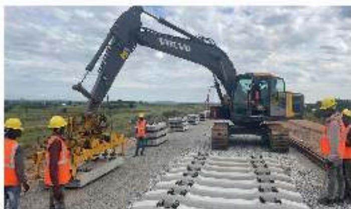
Kazi ya kuweka mataruma ikiendelea katika kipande cha tano cha mradi wa ujenzi wa reli yenye kiwango cha kimataifa - SGR Mwanza - Isaka, Juni 2023.
