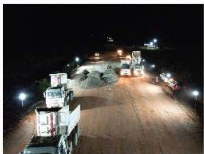
Kazi ya kujaza udongo katika tuta ikiendelea wakati wa usiku katika kipande cha tano cha mradi wa ujenzi wa reli yenye kiwango cha kimataifa - SGR Mwanza - Isaka, Juni 2023.
