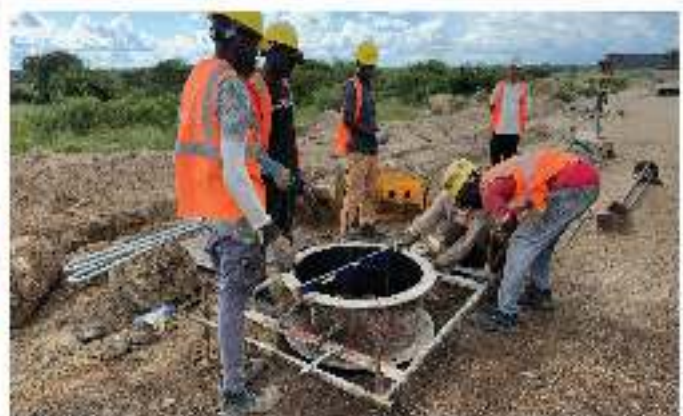
Wataalamu wikipima upana wa shimo kwaajili ya ujenzi wa msingi wa nguzo ya umeme katika tuta la reli yenye kiwango cha kimataifa - SGR akipande cha tano Mwanza - Isaka, Juni 2023.
