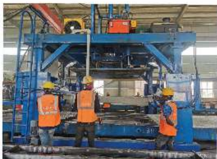
Mafundi wakiendelea na uzalishaji wa mataruma yanayotumiwa katika ujenzi wa reli yenye kiwango cha kimataifa - SGR kipande cha tano Mwanza - Isaka katika kambi ya Seke mkoani Shinyanga, Juni 2023.
